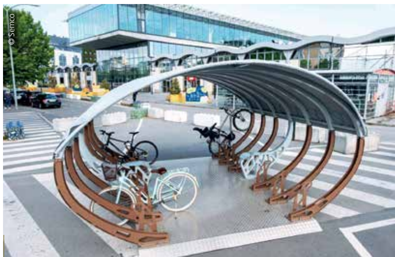
Constitué principalement d'une structure en acier, l'Abri de Transition et de Mobilité (ATM), proposé par Semco, est pourvu d'une couverture renforcée en toile polyester enduit de PVC, limitant les actions de vandalisme. Ici installé à Nantes, l'ensemble est design.
