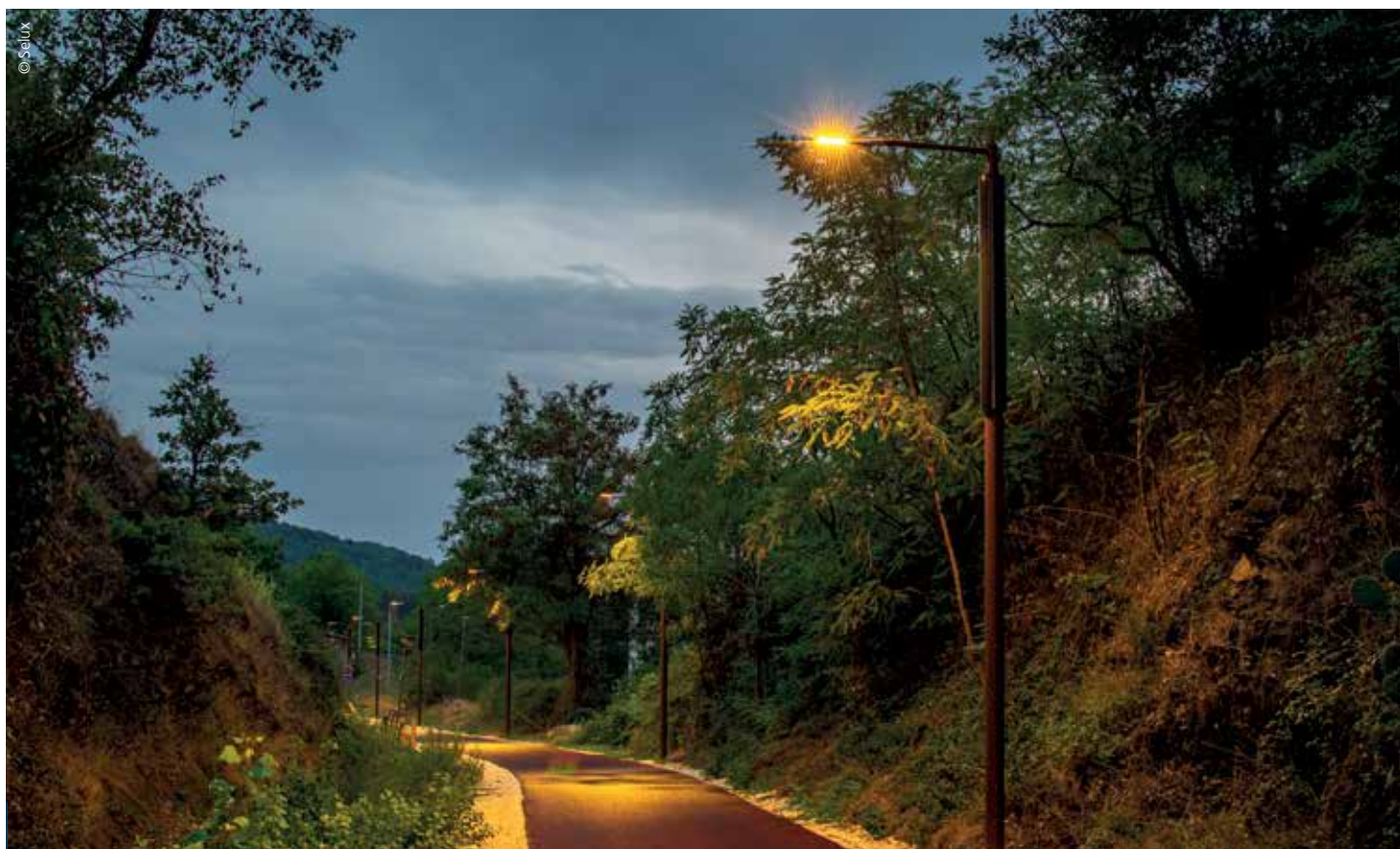
Les luminaires solaires (ici le modèle Antarès de Selux) fonctionnent de manière autonome : il n'y a pas de frais d'électricité ou de raccordement.
